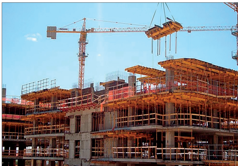
Figure 2. Sisteme flying forms : (b) metude in vore, viste di insiemi.
