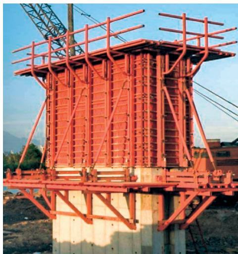
Figure 4. Sisteme jump forms : (b) viodude di insiemi de casseradure di un set.
