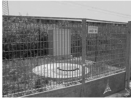
Figure 2. Postazion di depurazion de aghe.
