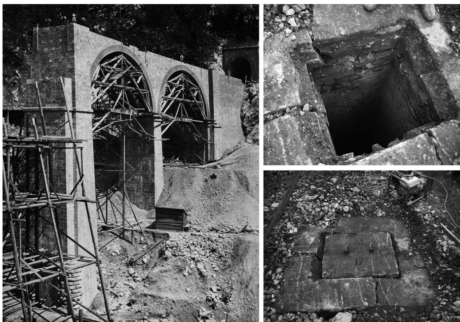
Figure 17. A man çampe, fase di costruzion des dôs arcadis di val dal puint (AA.VV. 2010). Tal pilon centrâl si cjate il fornêl di mine mostrât a man drete.
