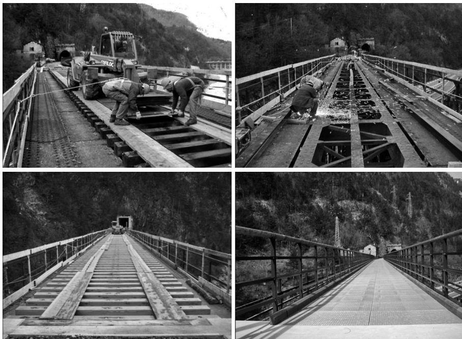
Figure 16. La costruzion de gnove solete. Adalt, si gjavin lis traversinis de ferovie e i cjami-naments in lamiere. Dabàs a man çampe si metin jù lis gnovis traversinis in laris lamelâr, a man drete la solete finide come che si presente cumò. Che si fasi câs ae messe in sigurece des mae-strancis cun imbragadure alpinistiche e colegament cun dissipatôr aes liniis vite laterâls.
