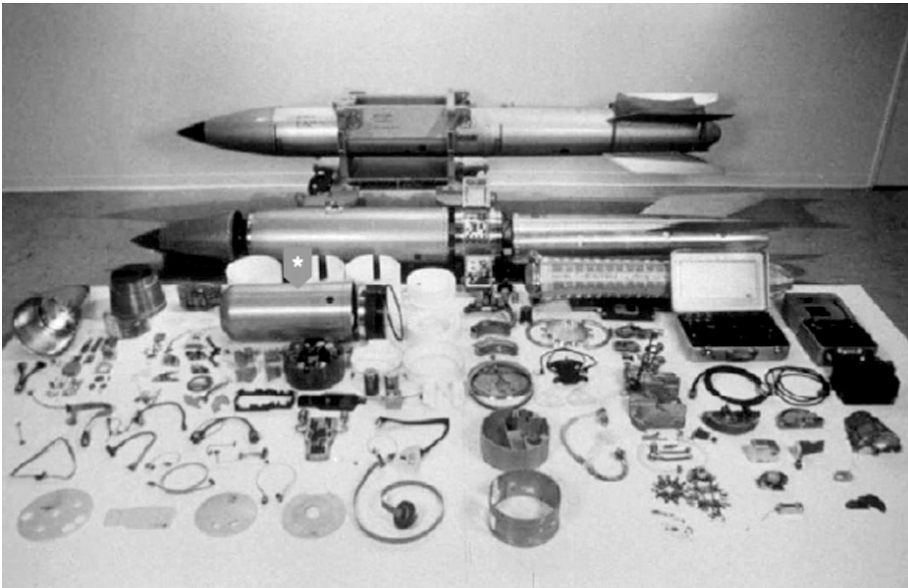
Figure 4. Components de arme nucleâr a gravitât termonucleâr B-61 di produzion americana. L'esplosîf nucleâr al è indicât cun (*) (Font: Ministeri de Energjie, Stâts Unîts).
